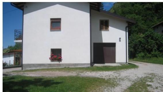
Slika 5 Konec vodovodnega odseka V1 ob stanovanjski hiši h.št. 47
